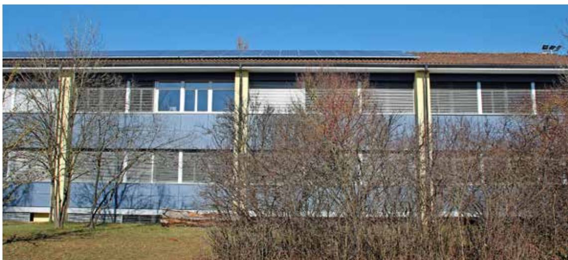
Das Oberstufenschulhaus Recken soll um eine Etage aufgestockt werden. Das Erscheinungsbild der Fassade soll erhalten bleiben. Bild: uf
