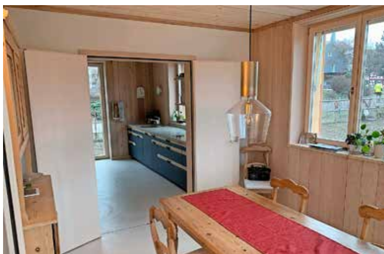
Blick vom Esszimmer in die Küche. Lehmverputzte Trennwand, Buchenholz auf der Fensterseite und Fichtenholz an der Decke.
