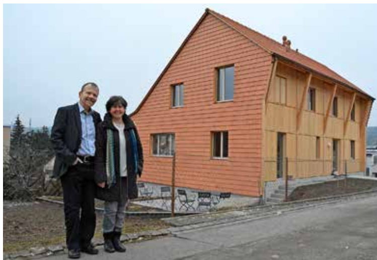
Richard und Doris Schärler vor ihrem neuen Wohnhaus. Die Süd- und die Nordseite haben sie mit Dachziegeln decken lassen. Bilder: vf
