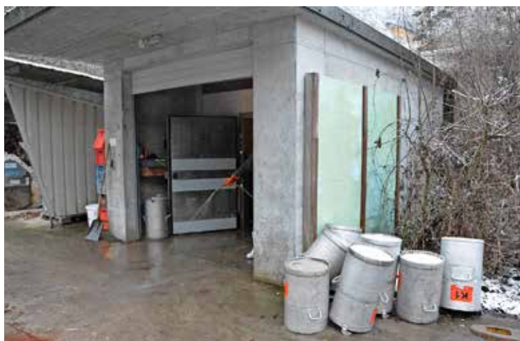
Die Sammelstelle für tierische Nebenprodukte von aussen. Rechts im Bild: ausgespülte Sammelbehälter aus Aluminium.
