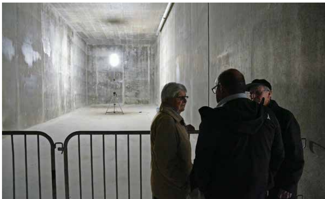
Die grössere der beiden Wasserkammern: Gefüllt fasst sie 750 Kubikmeter, ist 24,50 Meter lang und wegen des leicht geneigten Bodens zwischen 5,70 und 5,50 Meter hoch. Bild: vf
